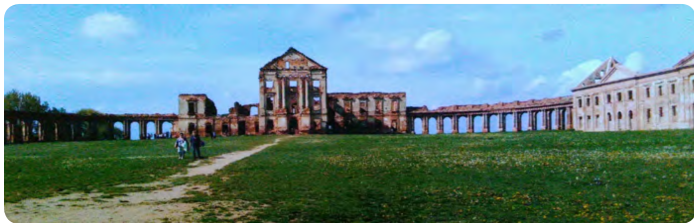
Znaczna część zamku Sapiechów czeka jeszcze na prace remontowe, fot. Halina Bondaruk
