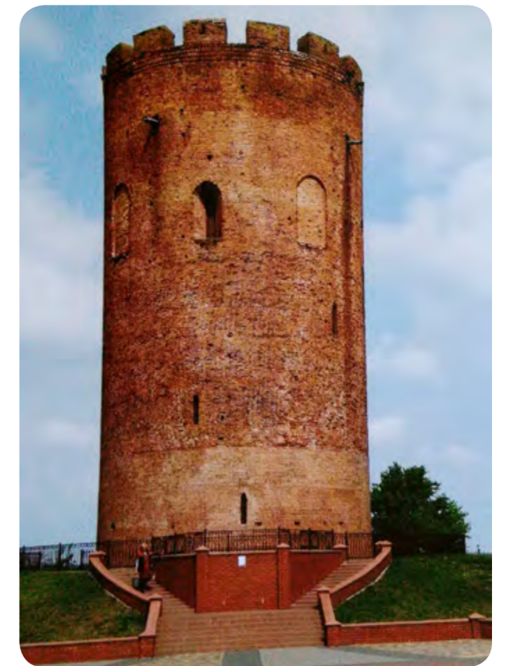
Zabytkowa wieża obronna w Kamieńcu Litewskim wzniesiona w połowie XIII w. Dzięki odpowiednio zastosowanym materiałom budowlanym i składnikom spoiwa (wapń jajka i krew dzikich zwierząt) nie nadwerżył jej czas i w dobrym stanie może przetrwać kolejne 700 lat - poinformowała nas przewodniczka. Obiekt położony jest na wzgórzu nad rzeką Leśna, ma wysokość 5 kondygnacji, fot. Halina Bondaruk
