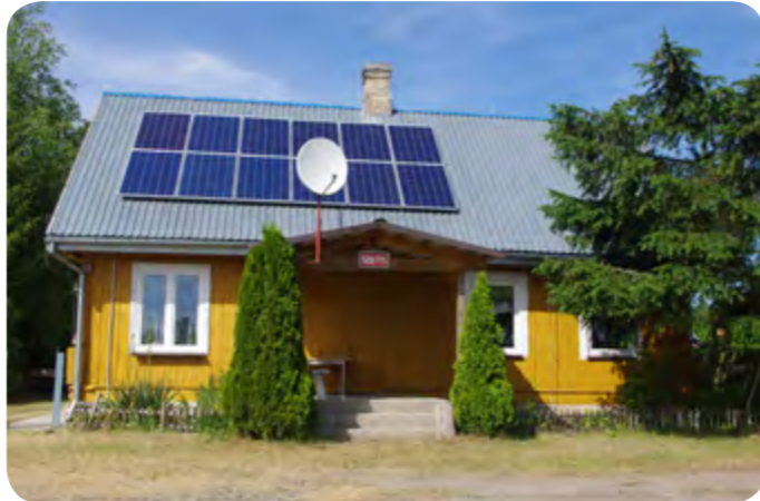
Instalacja fotowoltaiczna zamontowana w czerwcu w ramach projektu
