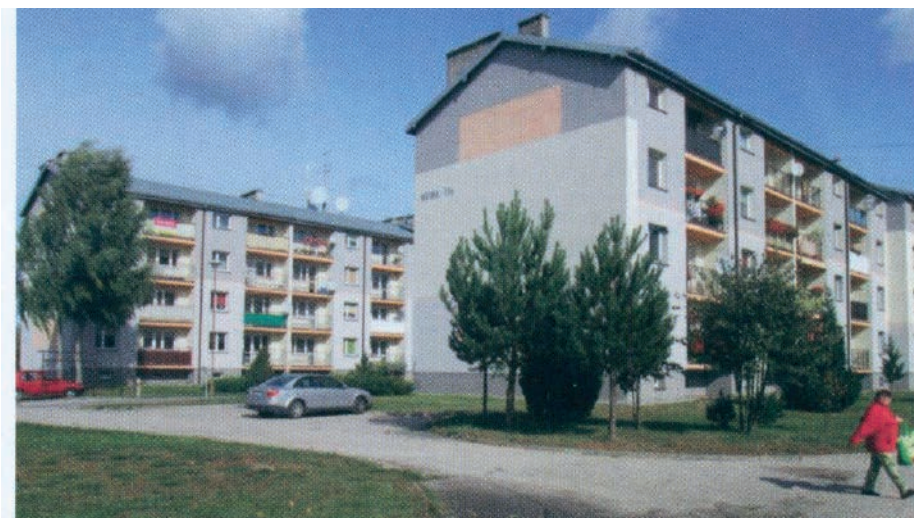
Bloki mieszkalne, zdj. Jan Cieluszecki.
