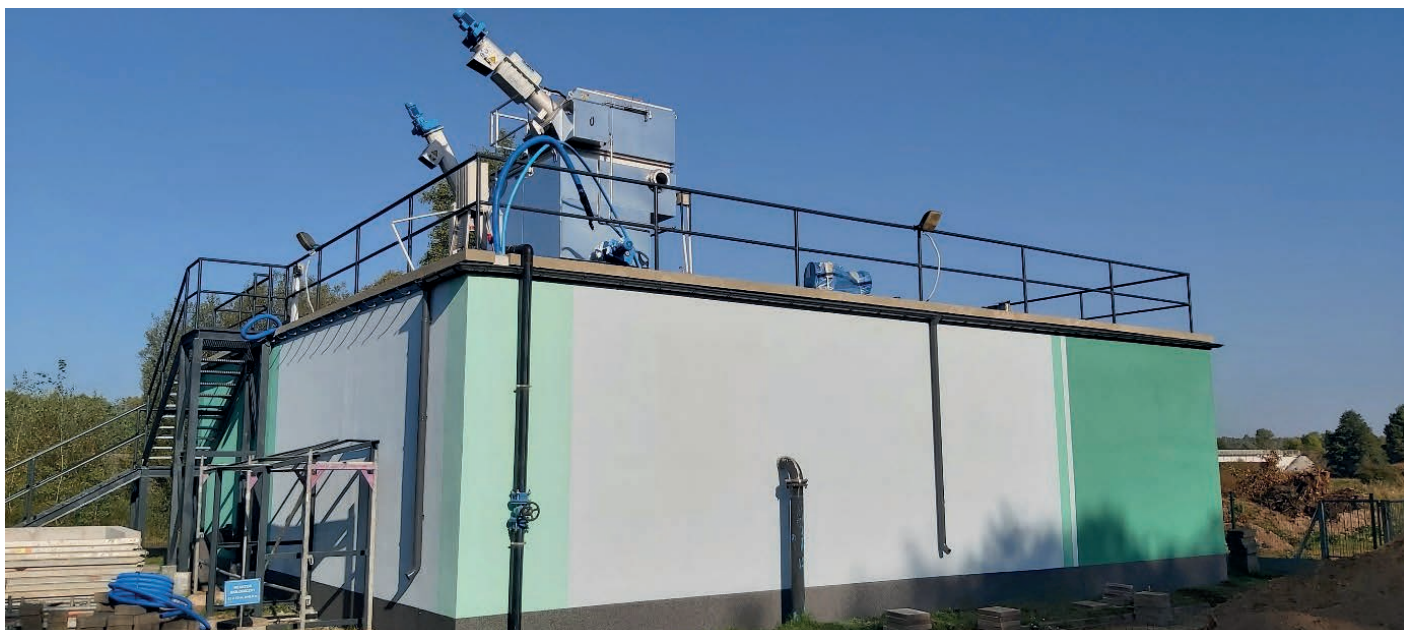
Modernizacja oczyszczalni ścieków
